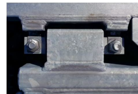
Torsjonskoblingen gir bevegelse i alle retninger
